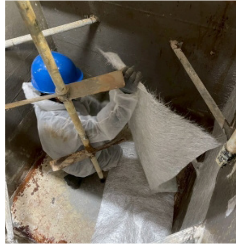
廢水廠二段馬達更換及曝氣槽整改工程 (FRP 包覆 + 馬達更換)
