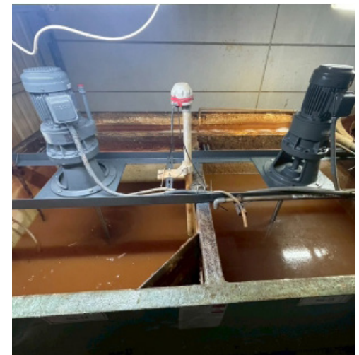
廢水廠二段馬達更換及曝氣槽整改工程 (FRP 包覆 + 馬達更換)
