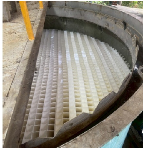
廢水廠一段化學系統槽體補強工程 - 沉澱槽修補 (FRP 包覆 + 濾材更換)
