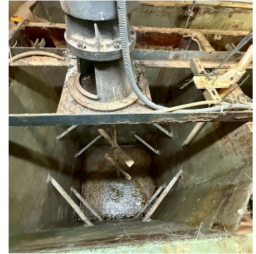
廢水廠二段馬達更換及曝氣槽整改工程 (FRP 包覆 + 馬達更換)
