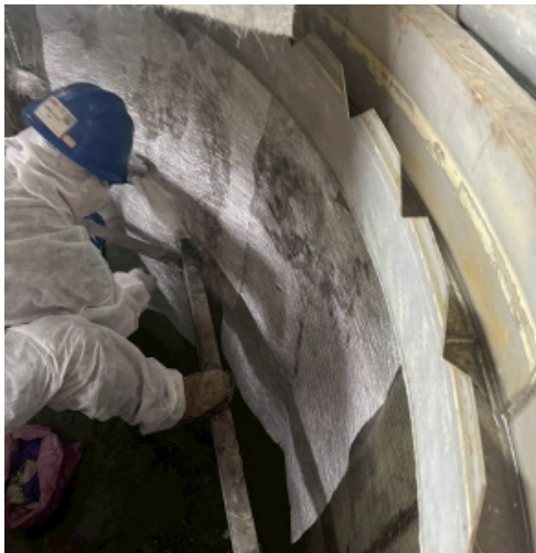
廢水廠一段化學系統槽體補強工程 - 沉澱槽修補 (FRP 包覆 + 濾材更換)
